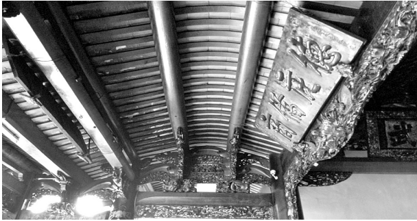
Hình 6. Cấu trúc vì nóc trước chánh điện
